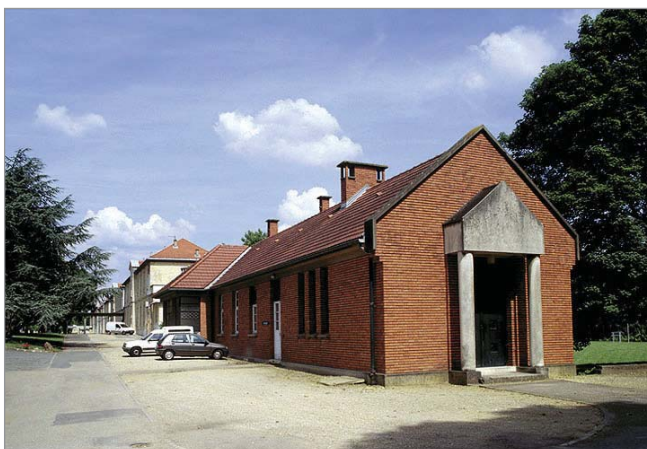
Hôpital psychiatrique de Ville-Evrard - Asile d'aliénés Amphithéâtre © Inventaire général, Département de la Seine-Saint-Denis, cl. J.-B. Vialles, ADAGP, 2003
