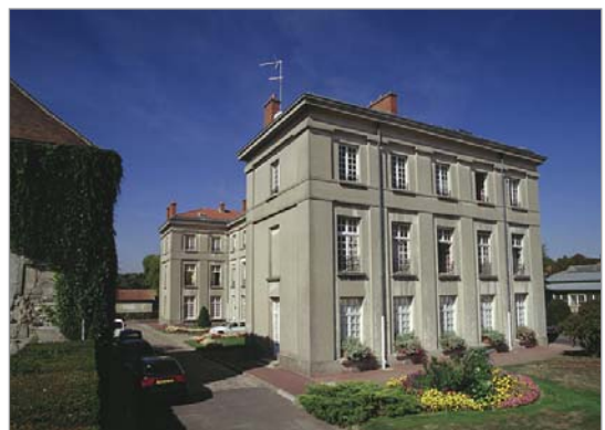
Hôpital psychiatrique de Ville-Evrard - Maison de santé Vue de l'ancien château Donzelot, transformé en bâtiment de service pour la maison de santé vers 1870.
