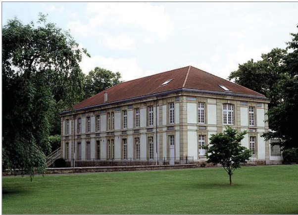
Hôpital psychiatrique de Ville-Evrard - Maison de santé Pavillon, Maréchal architecte, 1876-1880 © Inventaire général, Département de la Seine-Saint-Denis, cl. J.-B. Vialles, ADAGP, 2003
