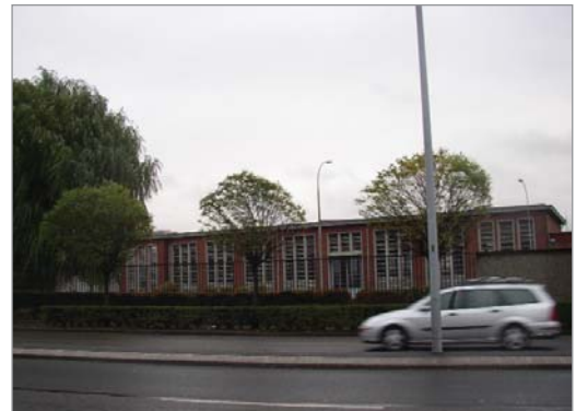
Usine des eaux - Usine élévatoire. 1954 20, boulevard du Maréchal Foch © CG93, DCJS, B pat, cl. MF Laborde, 2003 050inv001
