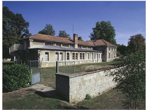
Hôpital psychiatrique de Ville-Evrard - Maison de santé Ancien pavillon cellulaire © Inventaire général, Département de la Seine-Saint-Denis, cl. J.-B. Vialles, ADAGP, 2003
