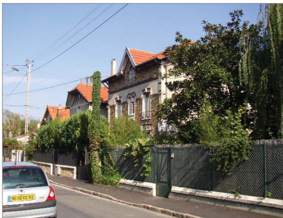
Quartier pavillonnaire du Pré fleuri.
