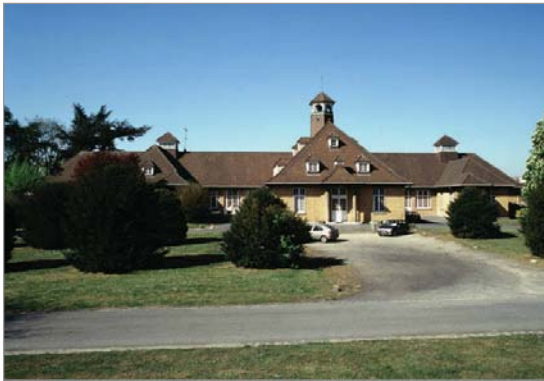
Hôpital psychiatrique de Maison-Blanche Sanatorium © Inventaire Général, Département de la Seine-Saint-Denis, cl. J.-B. Vialles, ADAGP, 2003
