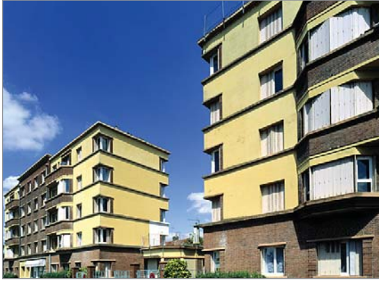
Cité-jardin. Immeubles collectifs 1934 79 rue Paul et Camille Thomoux, 60 rue du 11 Novembre
