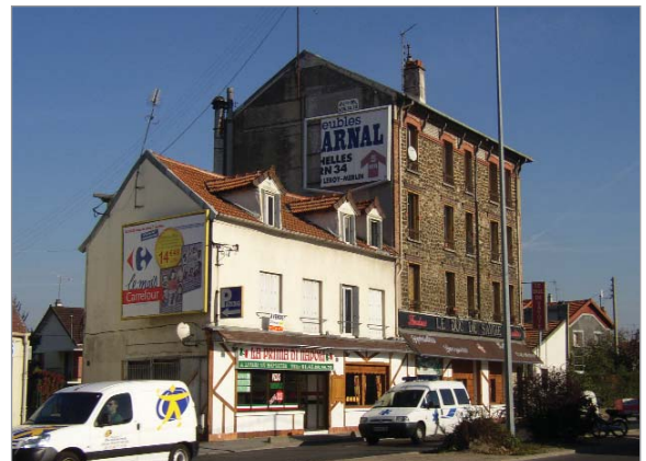
Ancienne auberge " A la descente de Ville-Evrard et de Maison-Blanche ". XIX e siècle 161 avenue du Maréchal-Leclerc © CG93, DCJS, B pat, cl. MF Laborde, 2003 050inv070
