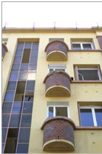
Cité-jardin. Immeubles collectifs Détail
